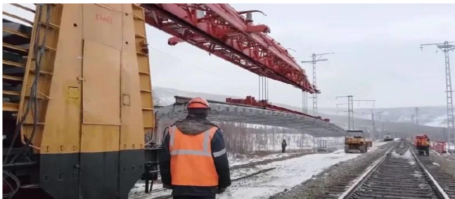
Рисунок 2- Работа укладочным краном, для укладки рельсошпальной решётки.
