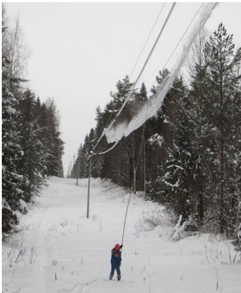
Рисунок. Удаление гололёда путём сбивания шестом
