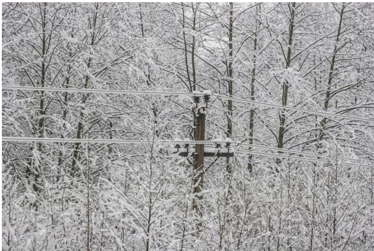
Рисунок. Гололедные отложения на воздушных линиях электропередачи
