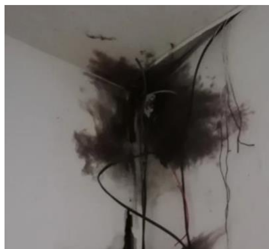
Рисунок 7. Последствия импульсного перенапряжения
