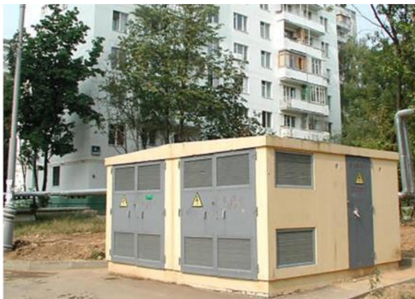
Рисунок 3- Разделительный трансформатор
